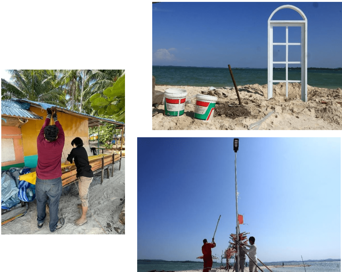
Gambar 7 Pemasangan Sistem penerangan, spot foto dan perbaikan instalasi listrik
