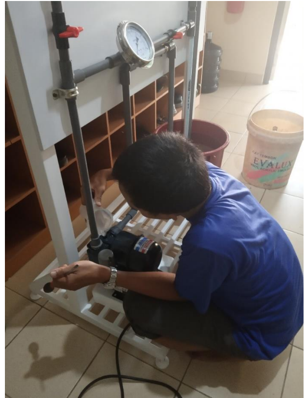
Gambar 4.1 Pembuatan Papan Penyangga dan Instalasi Peralatan
